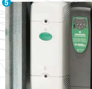
Nowy moduł napędowy o zmiennej prędkości obrotowej (VSD)
